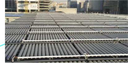
太阳能中温集热槽（供热、制冷、热水）
